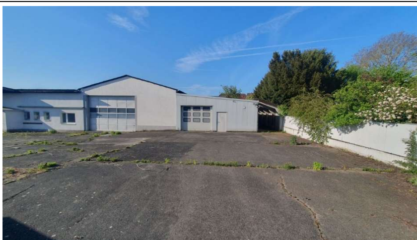
Abb. 2 (Ansicht von Norden): Westlich des ehemals gewerblich genutzten Geländes erstreckt sich eine schmale Gartenparzelle, die ebenfalls zum Plangebiet gehört. Hier stehen auch zahlreiche Gehölze.
